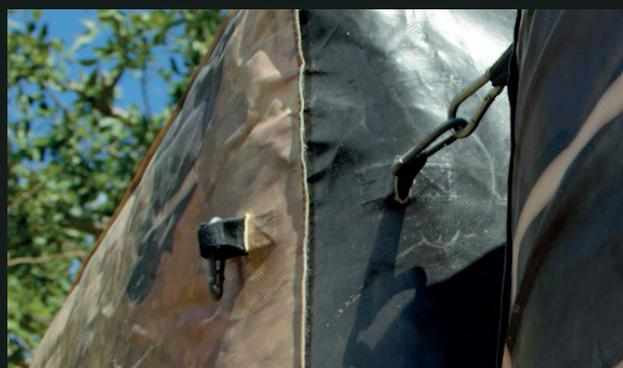
Fixation par mousquetons à de multiples points de connexion
